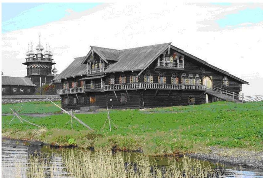
Рис. 9.3-6. Дом Ошевнева. Архитектурный заповедник Кижи.
